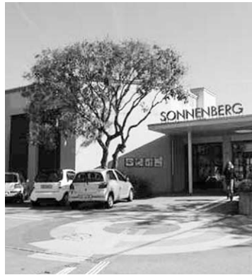
Eingang der Schule Sonnenberg
