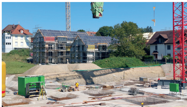
Baustelle Hinterdorf vom 8.8.2024
