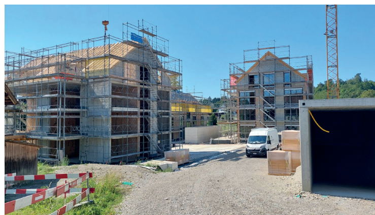
Die MFH des Obstgartens mit der Einfahrt zur Tiefgarage vom 13.8.2024
