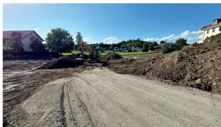
Aushubarbeiten für die Überbauung Obstgarten vom 8.8.2023
