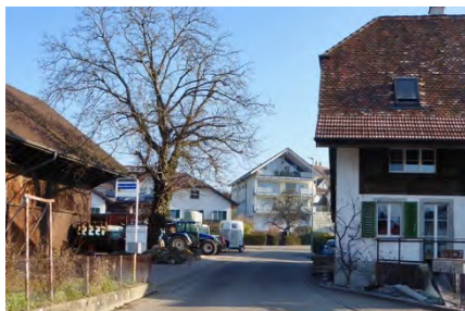
Abb. 6: Steigass mit diversen Gebäudestellungen und Vorzonen von alter und neuer Bausubstanz
