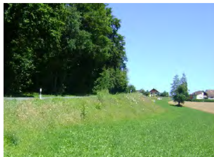
Abb. 31: Südliche Böschung im Kulturland, Foto arcoflan Juni 2020
